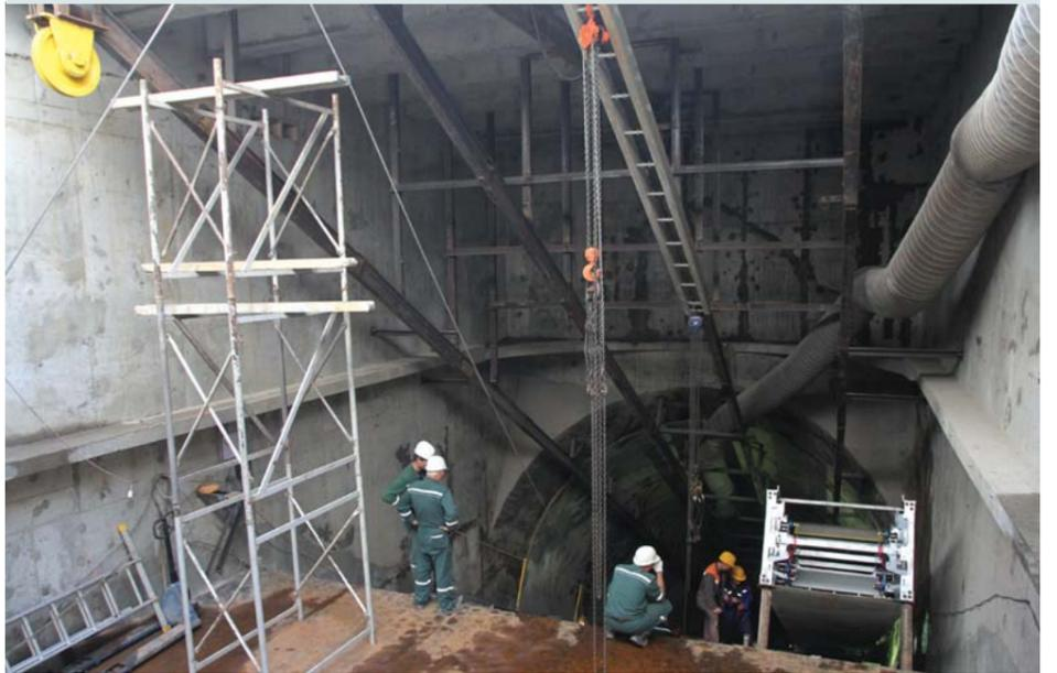
работах организации подписали «акт приемки работ», и бригады монтажников СМУ-9 приступили к опуску зон в машинный зал через технологический проем 9x2 м<sup>2</sup>, оставленный в перекрытии.
