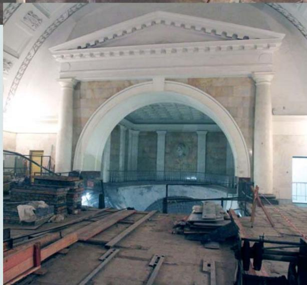
рического здания – нарушилась бы традиционная отделка вестибюля. В итоге, с подачи ЛМГТ и по согласованию с заводом-изготовителем было решено при установке эскалатора уменьшить угол его наклона на три градуса. Коллегам из СМУ-11 придется от середины наклонного хода подрубить восьмиметровый участок готового бетонного основания, подгоняя его под новый угол наклона.
