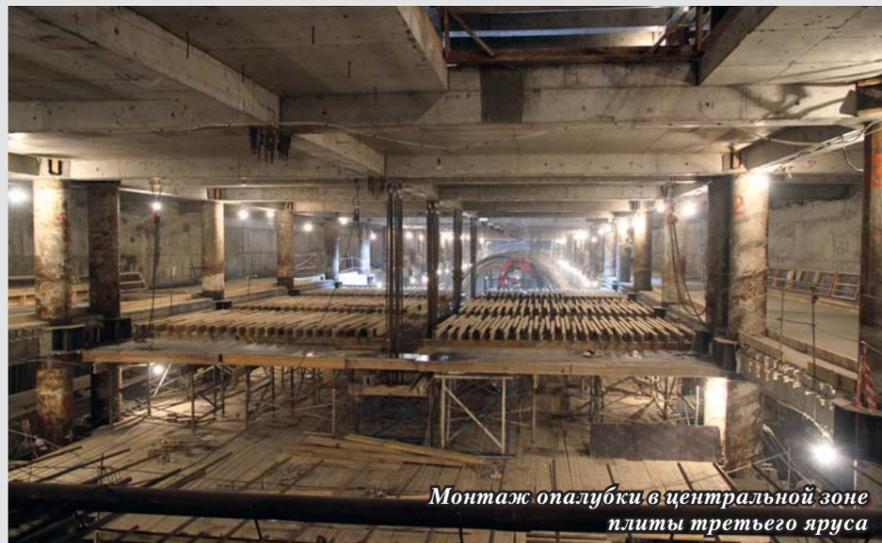
Монтаж опалубки в центральной зоне плиты третьего яруса
