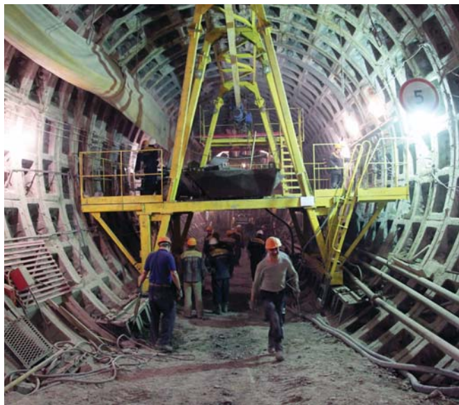
БРИГАДА ПРОХОДЧИКОВ АНДРЕЯ НИКОЛАЕВИЧА ЛЕБЕДЕВА ВЕДЕТ МОНТАЖ КОЛЬЦА В ПЕРВОМ ЗАБОЕ ПЕРЕХОДНОГО КОРИДОРА: А.В. Кузнецов, более 30 лет работает проходчиком в петербургском Метрострое; В.С. Морозов и С.В. Морозов – отец и сын – отличные проходчики; А.Н. Лебедев, бригадир; А.П. Кривоспитский, проходчик, ветеран Метростроя; С.Н. Иванов, проходчик; В.Д. Никитин, маркшейдер; Е.Р. Фриауф, проходчик; Д.Е. Кузин, проходчик; В.М. Терентьев горнорабочий
