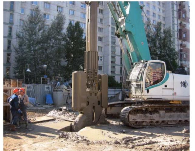
ный ствол частями поднимут на поверхность. Строящийся вентствол будет так же служить для спуска и подъема любого горнопроходческого оборудования, стройматериалов, для вывоза горной породы.
