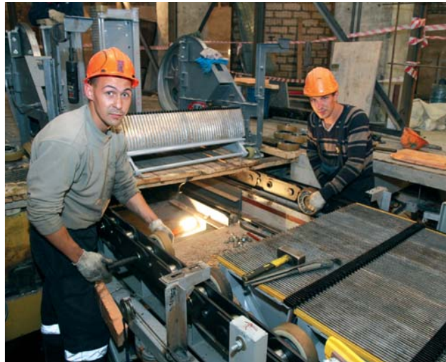
Электрослесари-монтажники ЗАО СМУ-9 «Метрострой» Сергей Николаевич Бобров и Алексей Валерьевич Афанасьев: «В СРОКИ УКЛАДЫВАЕМСЯ!»
