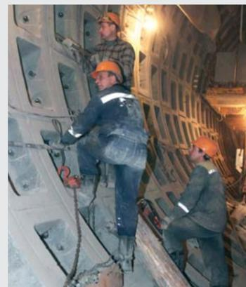
Проходчики ЗАО «СМУ №13 Метрострой» ведут монтаж сооружений переходного коридора. Для ускорения проходческих работ пройдена фурнель, разработана монтажная камера, в которой смонтирован второй укладчик УТ-5С. Проходческие работы в переходном коридоре идут в одном направлении двумя забоями.
