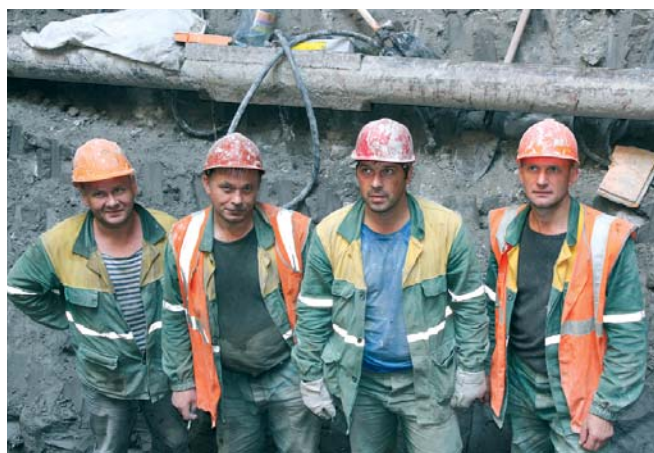
«ПОЗИТИВ»... Бригада Юрия Александровича Гусева (ЗАО «СМУ-11 Метрострой») на проходке наклонного хода станции «Спортивная-2»
