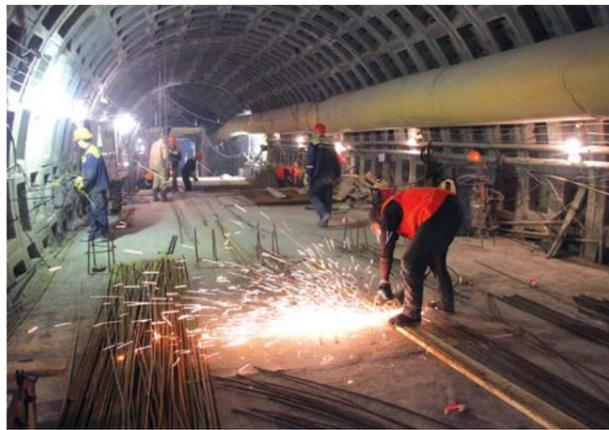
— Сначала по всей трассе переходного коридора мы построили банкетки — бетонные опоры плиты перекрытия, — рассказывает Василий, — ну а затем начали заходками армирование, монтаж опалубки и бетонирование. Толщина плиты основания — 550 мм, длина разовой заходки 12 метров, на заходку идет порядка 50 м<sup>3</sup> бетона.
