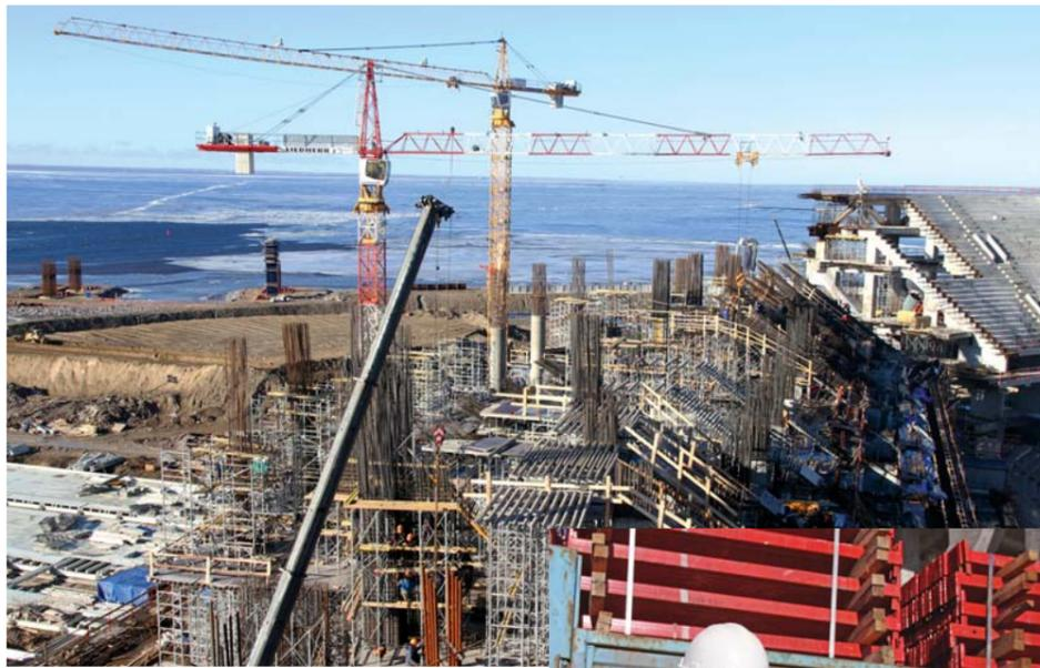
рядок армирования, разбирают сложные узлы рабочего участка. Геодезисты представляют исполнительные схемы, на основе которых устанавливается опалубка под предстоящее бетонирование. Далее опалубка принимается заказчиком и дается «отмашка» на ведение бетонных работ.
