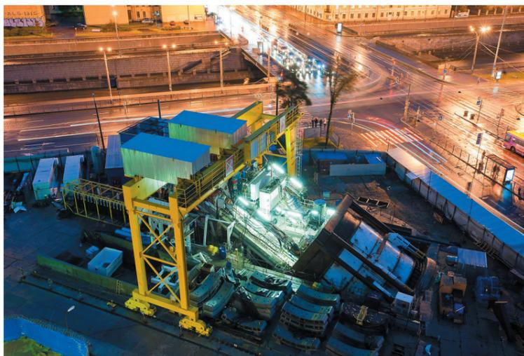
Объект №1 – станция «Обводный канал». Сегодня здесь полным ходом продолжается установка «колец» наклонно-эскалаторного хода.
