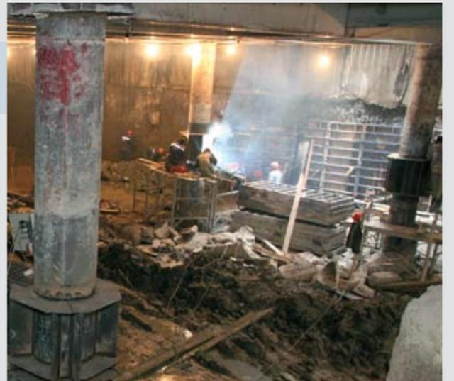
– Еще начали достраивать демонстрационный котлован и готовимся к проходке 14-метровой горизонтальной штольни, которая соединит котлован со станцией. Зачем это делается? Во-первых, это позволит в определенный момент разгрузить пространство станции и примыкающего участка двухпутного тоннеля и тем самым ускорить работу. Во-вторых, штольня будет играть роль своеобразного упора при проходке щитом станционного котлована.
