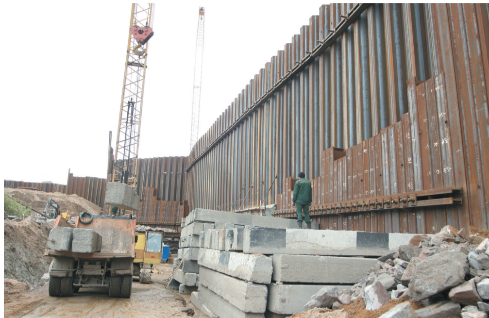
Строительство локального котлована на южной части объекта
