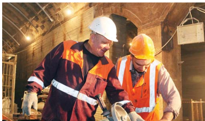
Бригада камнетесов СМУ-19 ведет отделочные работы в шахте № 622 («Международная»)
