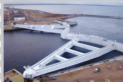
2009 год – введены в действие доковые камеры и ботапорты судопропускного сооружения С-1
