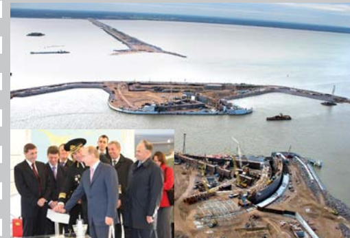
2008 год – судопропускное сооружение С-1 сдано в эксплуатацию
