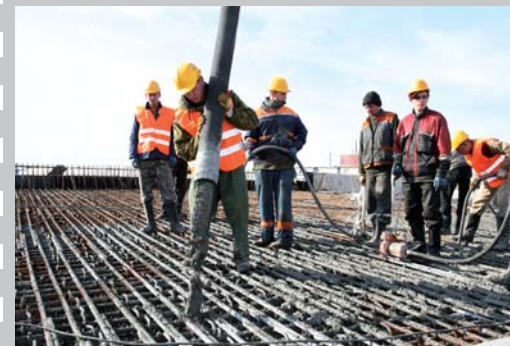
2010 год – последний куб бетона на «крышу» тоннеля уложен
