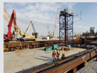
Специалисты SKW, совместного предприятия Skanska, Kiewit и Weeks Marine, начали погружение первого из 11 кессонов на строительстве речной переправы в штате Вирджиния (США). Масса одного кессона составляет 16000 тонн. Первые шесть кессонов готовятся к погружению в морском терминале Портсмута. Последние пять – ожидают своей очереди на бетонном заводе в штате Мэриленд. Специалисты планируют затрачивать на установку каждого из них 5 недель.
