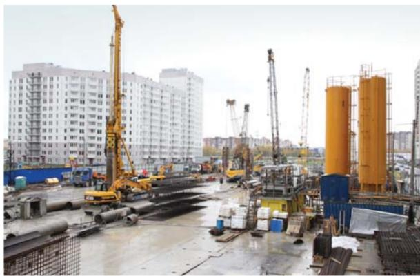
«Геострой» сможет производить строительство стены в грунте по радиусу котлована заходками в шахматном порядке: одна заходка разрабатывается, другая – бетонится. Заходка за два дня – к таким темпам необходимо стремиться на участке
