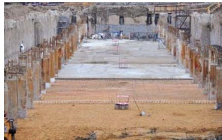
В конструкции перекрытия заложены три технологических отверстия: через них предполагается отгружать грунт при углублении котлована. На самом деле, решений о выемке грунта несколько, например, конвейерами или экскаваторами. Технология этого этапа
