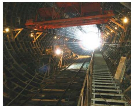
го набираем леса и на весь забой бетонируем стену. Далее вырубает в ней трехметровую штольню и начинаем разработку верхней части тоннельной выработки – раскрываем калотту. По всему периметру сводовой части устанавливаем деревянную крепь, затем на трехметровом участке свода монтируем постоянные конструкции – рамы, крепим
