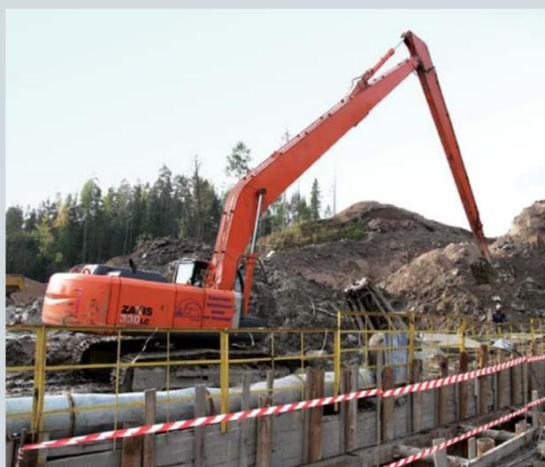
условиях процесс сооружения происходит необычно. Шпунт не забить – валуны, открытым способом без крепления идти нельзя. Приходилось комбинировать и бурение скважин, и специальные затяжки... Вот и получается, что проблем было больше при строительстве шахты, а не самого тоннеля.
