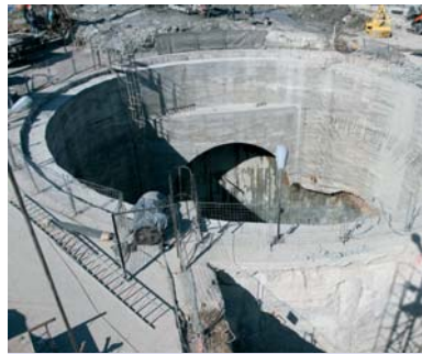
Стартовый котлован. Через несколько дней будет пробит проем в направлении галереи
