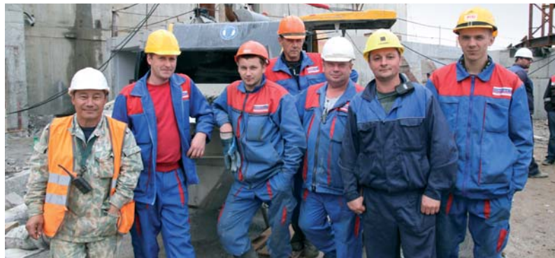
Комплексная строительная бригада слесарей ЗАО «Компакт». Бетонирование очередного яруса внутренней защитной оболочки. Слева направо: Ж.С. Балниязов, стропальщик; А.А. Баженин, слесарь; В.В. Грохотов, слесарь; К.Б. Иванов, слесарь; А.В. Неделко, бригадир; В.В. Батриков, оператор бетонораздаточного насоса; А.И. Попов, слесарь
