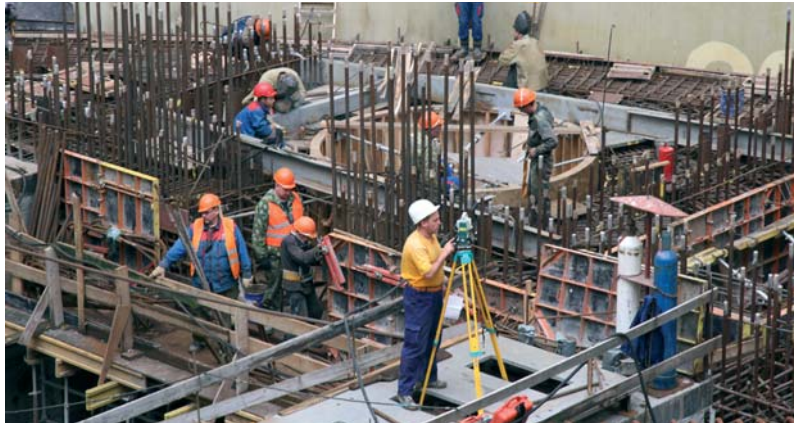
Строительство перекрытия на +14.500 м
