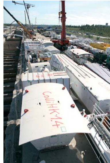
Первые фрагменты нового горнопроходческого комплекса ТПМК проекта S-782 на стройплощадке «Южной»
