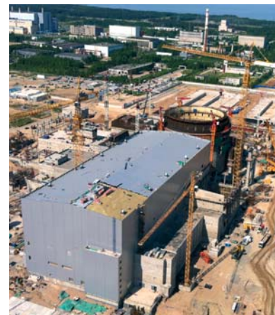
Управление механизации на строительстве стапеля для подачи деталей на реактор
