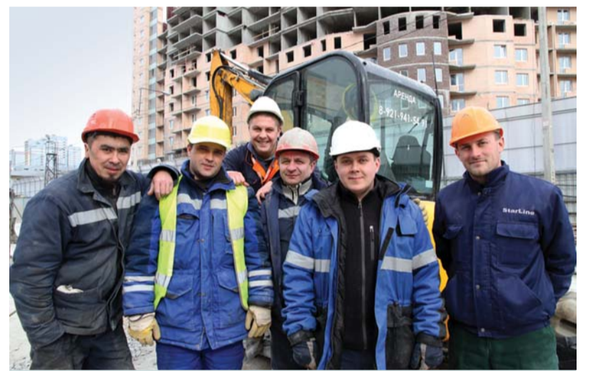
Отличная бригада проходчиков-универсалов. Сейчас ребята успешно занимаются гидроизоляцией подготовленного участка галереи
