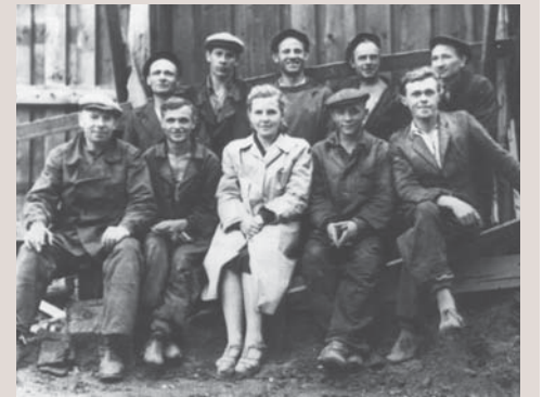
Бригада Марии Ивановны во время монтажа подстанции на углу ул. Шкапина и набережной Обводного канала
