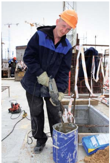
Монтажник ЗАО «Тоннельный отряд-3» В.П. Беликов: «Работаем помаленьку...»
