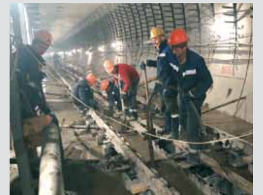
Укладка путевого бетона – тяжелая «ручная» работа. Но без нее никто нигде не поедет. Поэтому 100 метров путевого бетона в смену, а иногда и больше выдает бригада бетонщиков СМУ-15. И спи-отдыхай!
