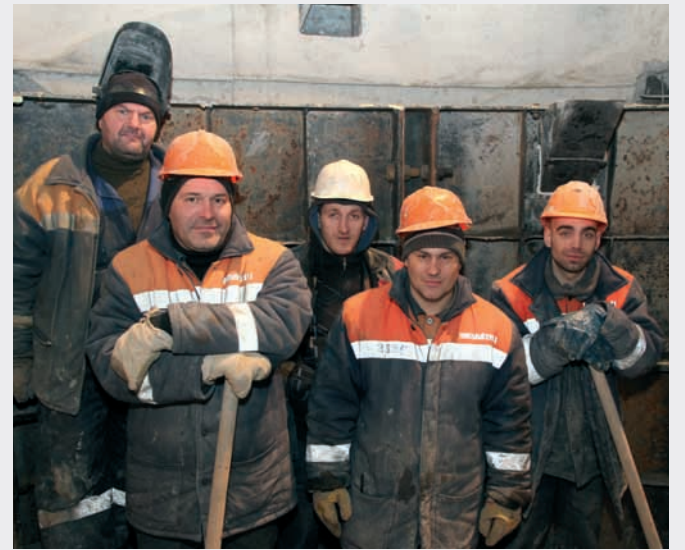
Проходчики бригады Е.В. Ширяева ведут работы по раскреплению опалубки
