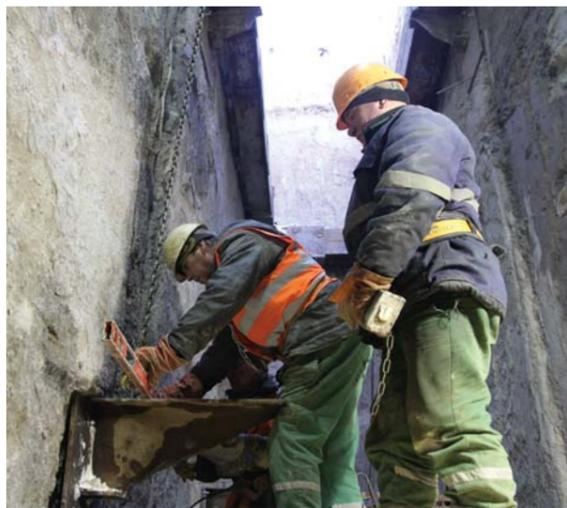
На день подготовки информации (26 декабря 2014 г.) бригады СМУ-11 выполнили монтаж и бетонирование более трети площади верхнего перекрытия станции «Дунайский проспект»: из 205 метров плиты залито 80. Подготовка к бетонированию четвертой из десяти заходок включает армирование, монтаж закладных, оформление проемов, установку отсечки и т.д. О ходе работ рассказывает заместитель начальника участка СМУ-11 Вячеслав Суходолов.
