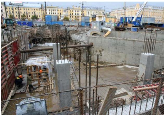
Продолжаются буровые работы на строительстве вестибюля: на момент подготовки информации из 96 буронабивных свай забурено 50 – перешли на вторую половину. Выполнена первая захватка железобетонной плиты основания машинного помещения, ведется бетонирование армокаркасов колонн, поднимаются ограждающие стены. Монтажники участка № 1 ЗАО «СМУ № 13 Метрострой» приступили к бетонированию следующей захватки – непосредственно в районе наклонного хода.
