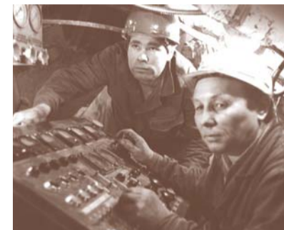
С помощью Ясиноватских щитов в 1981 году установлен мировой рекорд скоростной проходки – 1250 метров в месяц
