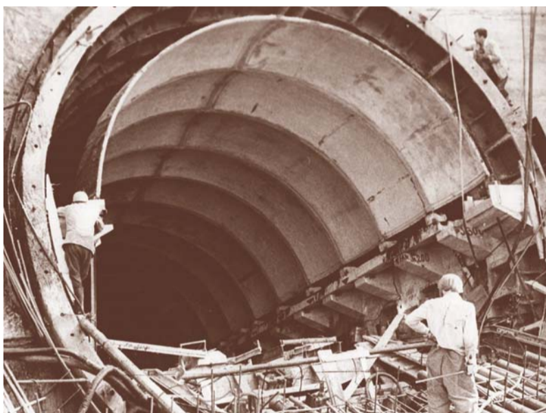
Монтаж зонтов наклонного хода. 1970-е годы
