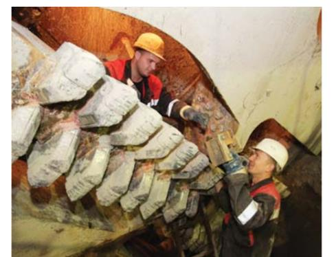
Высококласные электрослесари-монтажники Управления механизации ОАО «Метрострой» Д.М. Мудрицкий и В.В. Суббота. Демонтаж режущих элементов щита
