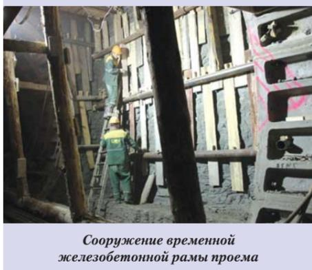
Сооружение временной железобетонной рамы проема
