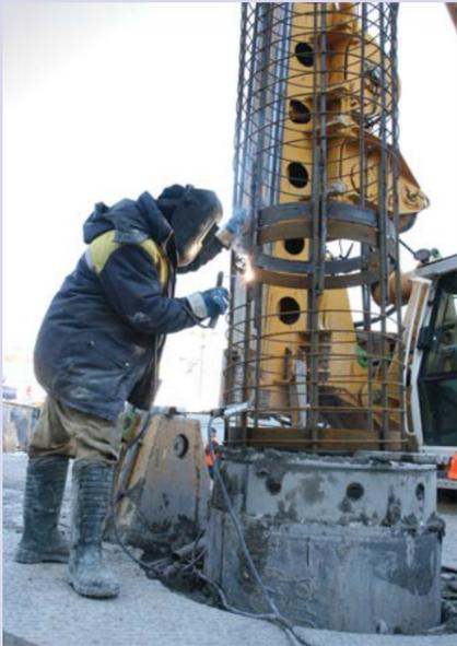
**В марте на строительной площадке вестибюля и наклонного хода станции «Спасская» началось бурение скважин под сваи по контуру будущего котлована – отправной точки для тоннелепроходческого комплекса. Планируется, что собственный выход на поверхность станция получит в 2013 году.**
