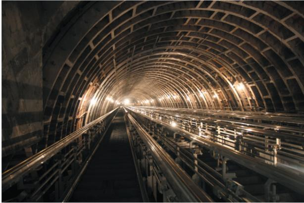
«Волковская» – пилонная станция глубокого заложения. Первоначально планировалось строительство односводчатой станции, но для удешевления и ускорения строительства проект был изменён на колонную, а затем на пилонную. Пилонный проект был принят в 2004 году и сразу начал реализовываться.
