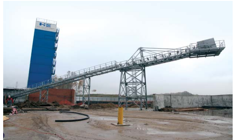
Управление механизации начинает сборку тоннельного конвейера. На строительной площадке ЗАО «Управление-15 Метрострой» вырос синий «зуб» башины-накопителя: восемь поставленных один на другой портовых контейнеров, внутри которых смонтированы секции для укладки транспортной ленты. Ленты должно быть много. По тоннелю лента отгрузочного транспортера проползет за щитом четыре километра, вынырнет на поверхность и по транспортному мосту потащит породу в отвал
