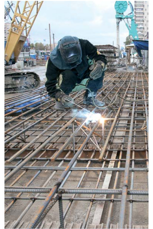
Сварку армокаркасов выполняет сварщик Николай Александрович Блинов
