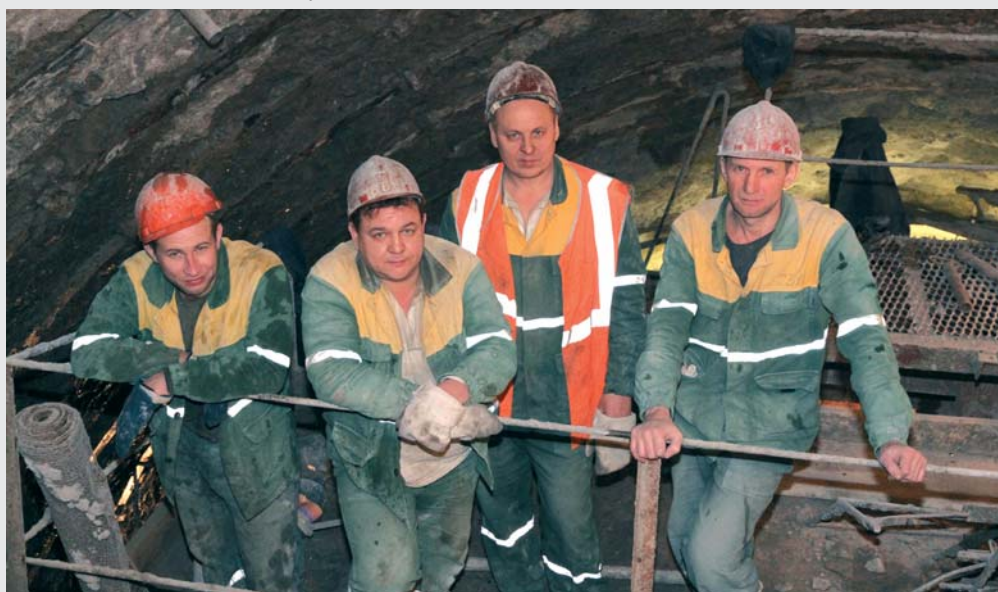
У торцевой стены наклонного хода станции «Спортивная-2» бригада Юрия Александровича Гусева (ЗАО «СМУ-11 Метрострой»)
