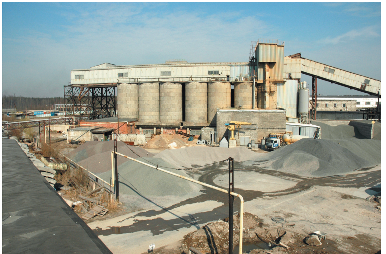
«Сердце» предприятия – бетонный завод
