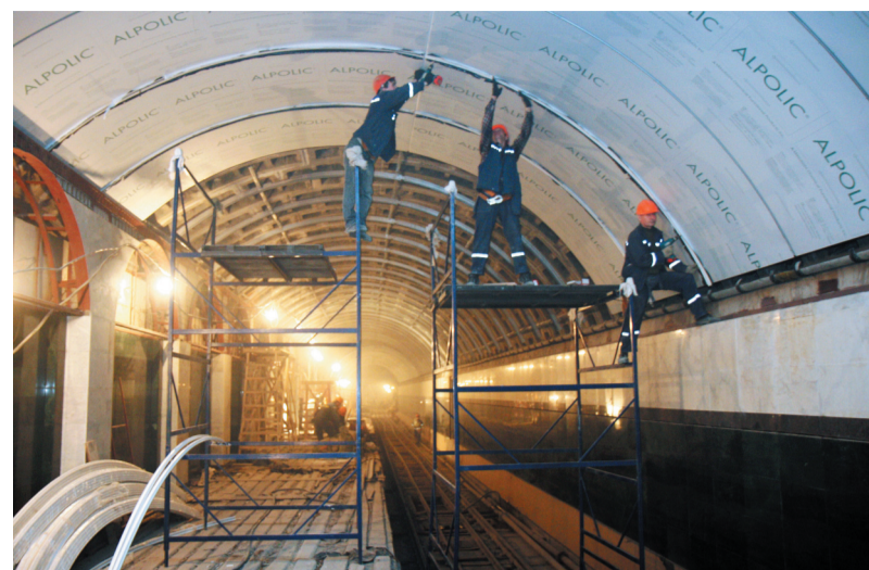
Окончание монтажа «зонтов»
