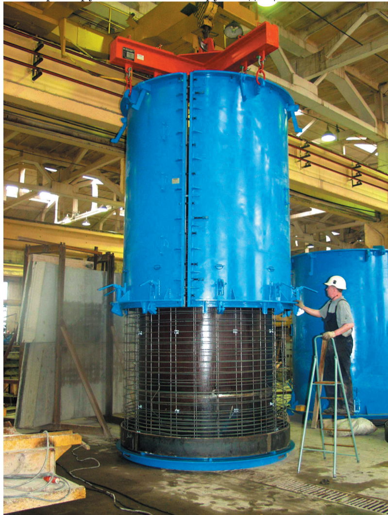
Подготовка трубы для микротоннелирования к заливке бетона
