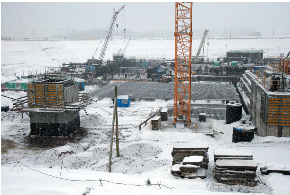
ЛАЭС-2: стройплощадка Метростроя
