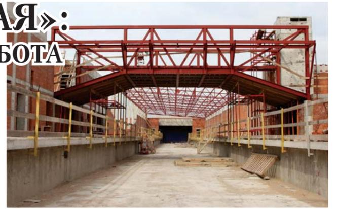
(одна треть площади крыши) нет еще и ферм каркаса. Монтаж каркаса могли делать уже летом, но... Опять же – пресловутый финансовый вопрос. Нужны деньги, и тогда в течение месяца «Метромаш» мог бы поставить нам фермы и собрать их. Хотя монтировать на высоте двутавровые балки зимой, конечно, менее приятно, чем летом. Крыша – это летняя работа.
